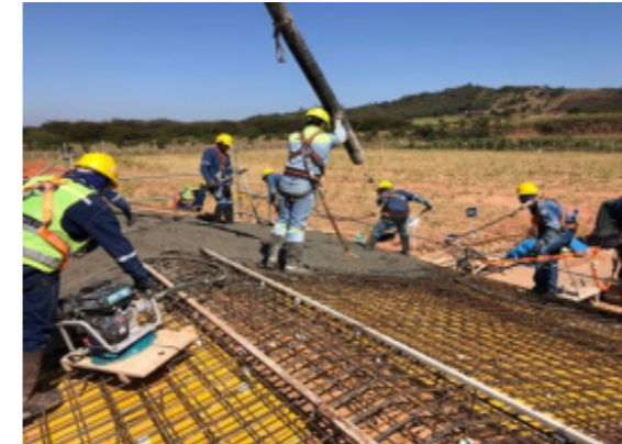
Construcción Subestación Las Brechas
