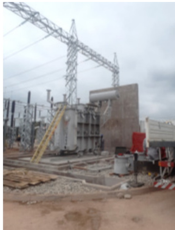
Montaje del Transformador y alimentadores a cargo de SETAR, Subestación Bermejo
