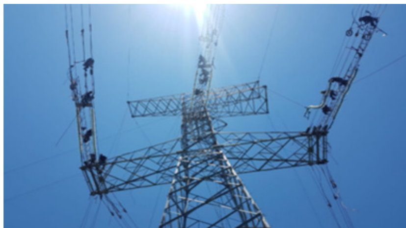
Tendido de Línea Carrasco – Santivañez
