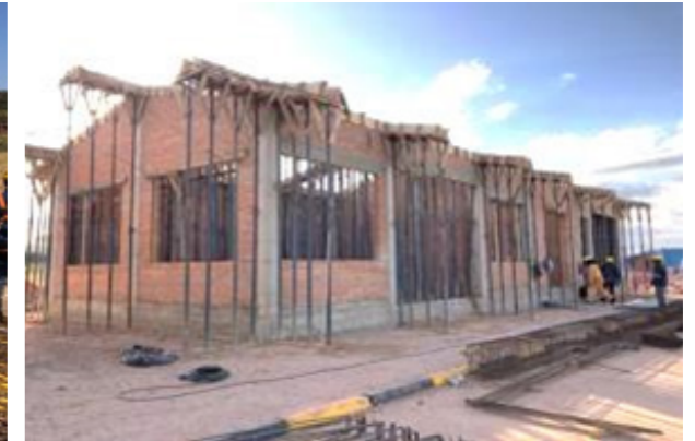
Obras civiles, Subestación Las Brechas
